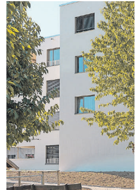
Die Aussenarbeiten sind fast abgeschlossen.
