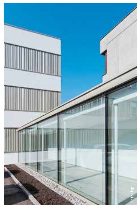
Das neue «Haus der Medizin» in Brugg ist ein Erweiterungsbau des medizinischen Zentrums.
