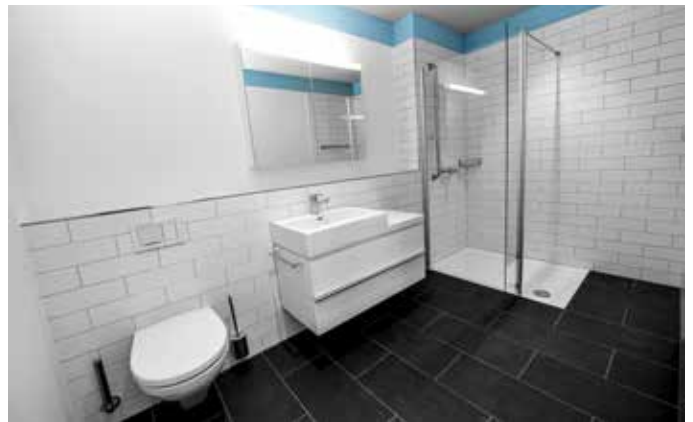
Die Badezimmer sind mit schwellenlosen Duschen ausgerüstet – und so geräumig, dass Rollstuhl und Assistenzperson bequem Platz haben.
