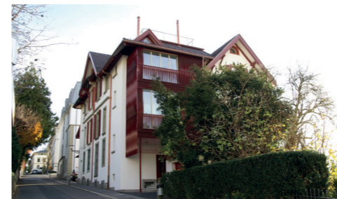
Umbau Wohnhaus Adligenswilerstrasse Luzern
