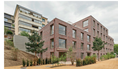
Mehrfamilienhaus St. Karlstrasse Luzern
