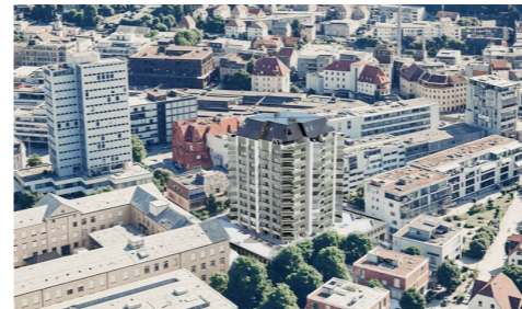
Sanierung Hochhaus Gstuhl, Baden
