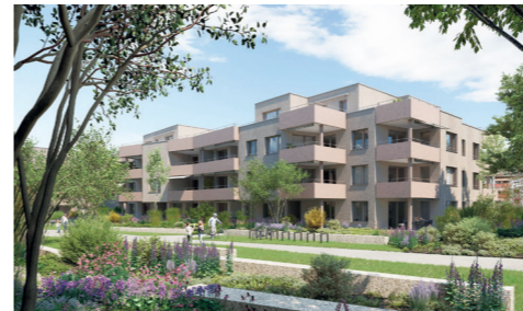
Wohnüberbauung Mattenpark Othmarsingen
