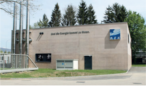
Neubau Energiezentrale Bellach
