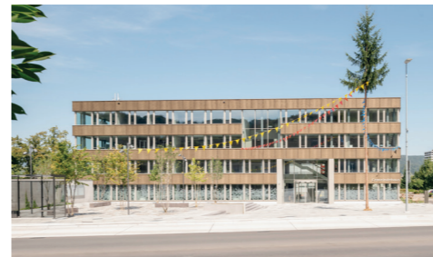
Neubau Gemeindehaus Spreitenbach
