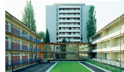
Sanierung Siedlung Spitalstrasse Luzern
