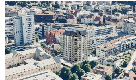
Sanierung Hochhaus Gstühl, Baden
