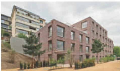
Mehrfamilienhaus St. Karlstrasse Luzern
