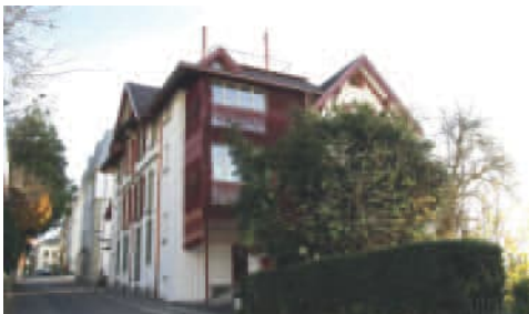
Umbau Wohnhaus Adligenswilerstrasse Luzern
