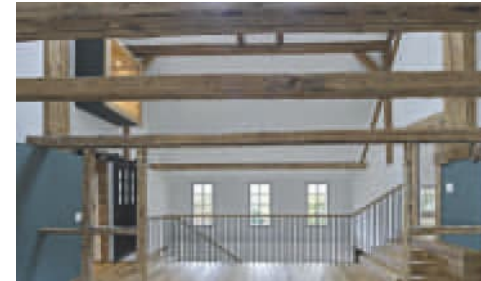
Umbau ehemaliges Bauernhaus Solothurn
