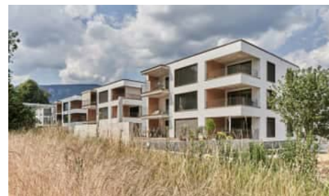
Neubau Mehrfamilienhäuser, Feldbrunnen
